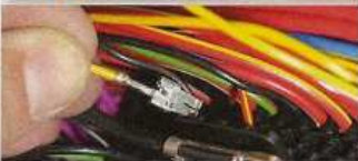
4 Plus über Reparaturleitung 000 979 135 auf freien Platz mit Zündungsplus im Sicherungskasten
